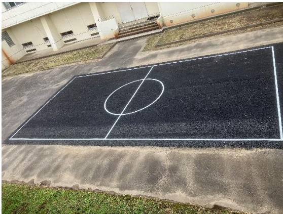
完成したドッジボールコート
